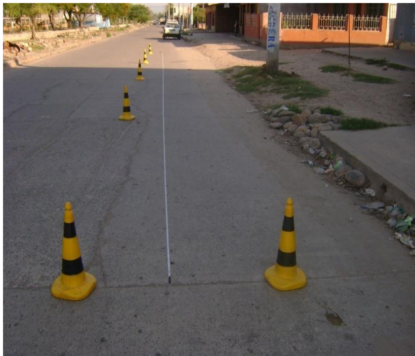
Fig. 3.4 Equipo de seguridad vial
