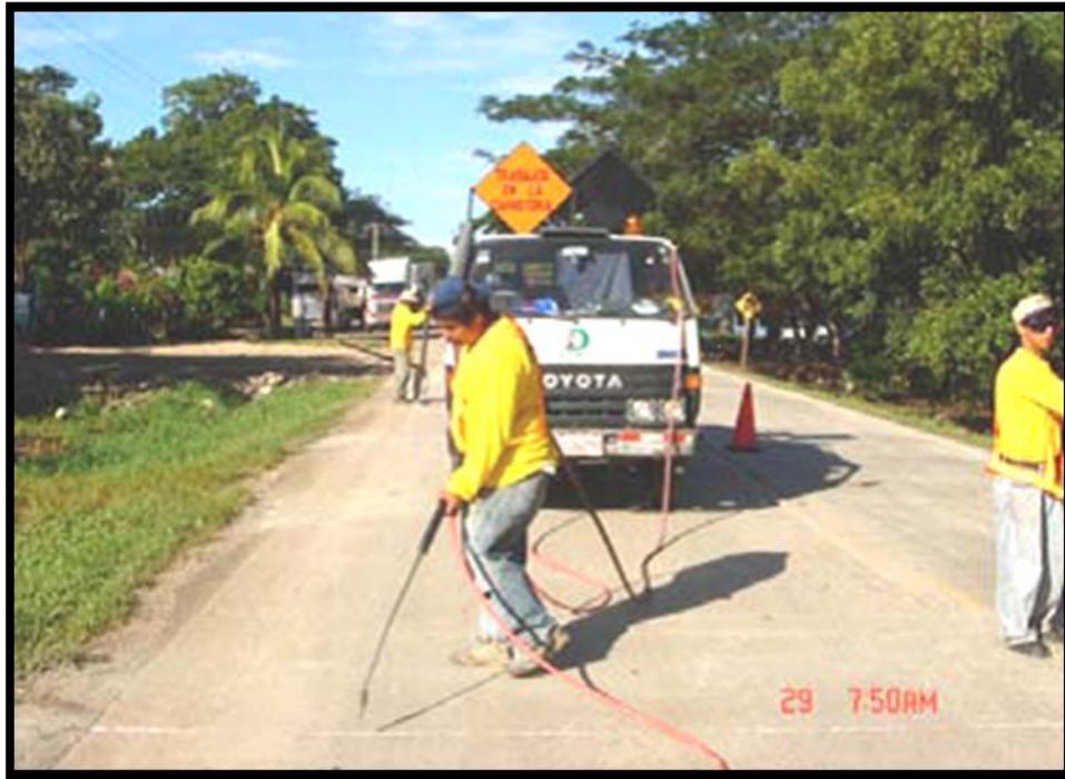
Fig. 4.12 Limpieza de juntas
