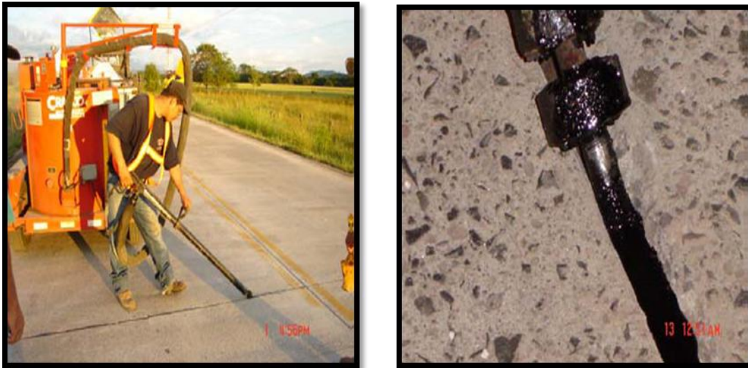
Fig. 4.13 sellado de juntas
