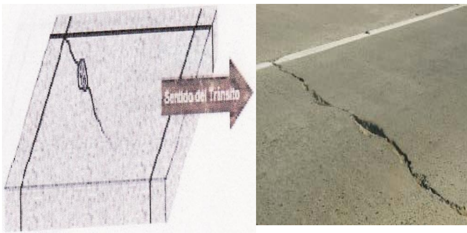
Fig. 2.8 Fisuras inducidas
