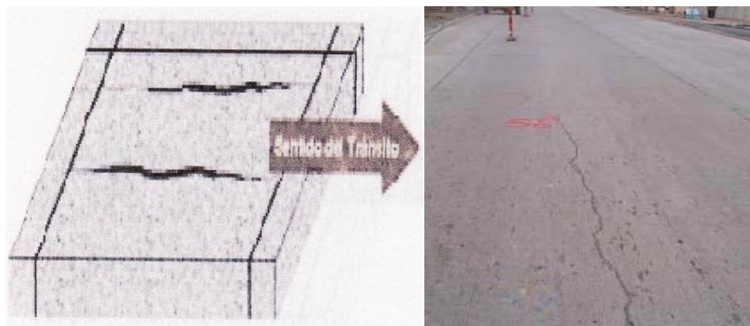
Fig. 2.4 Fisura Longitudinal
