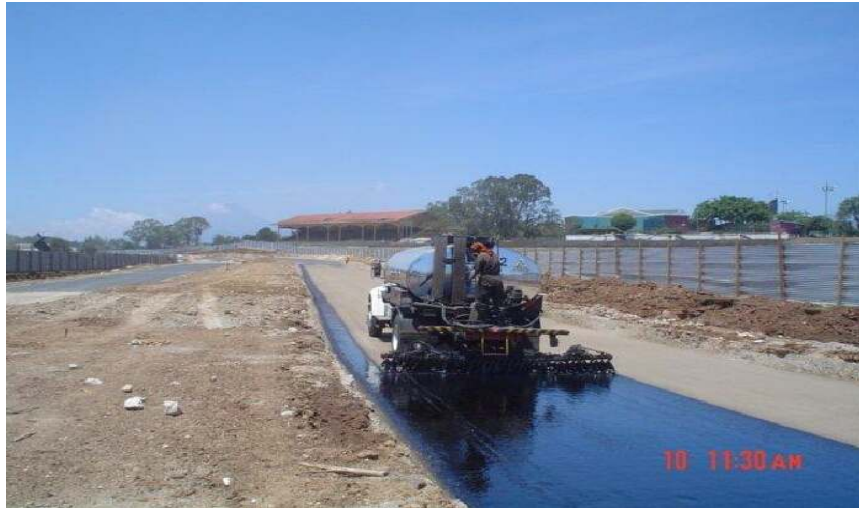
Figura 8. Estabilización en subrasante
