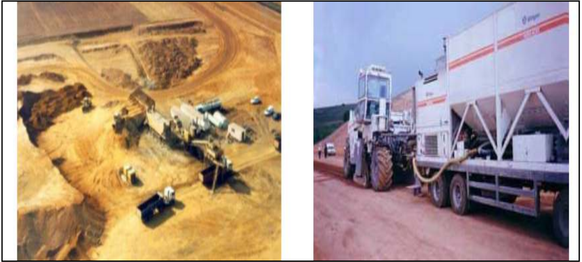
Figura 7. Estabilización en planta y estabilización in situ con cemento
