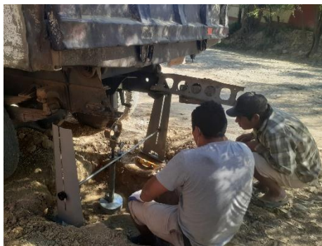
Figura 3.9 Preparación para realizar el ensayo de C.B.R. in situ y densidad in situ
