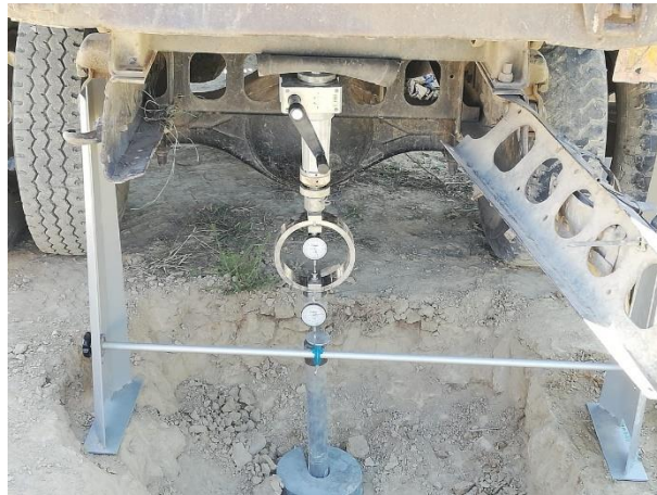
Figura 3.11 Montaje del equipo de C.B.R. in situ
