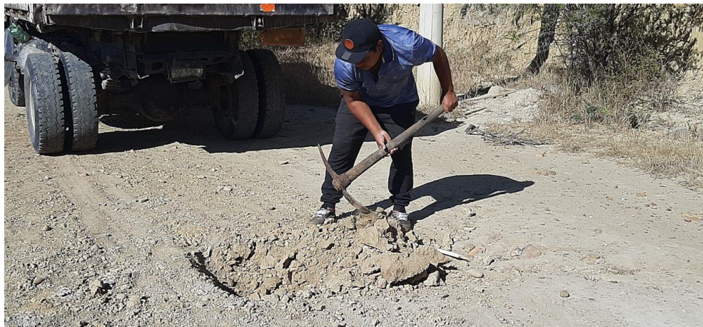
Figura 3.8 Excavación de calicata para extracción de muestras y ensayos in situ
