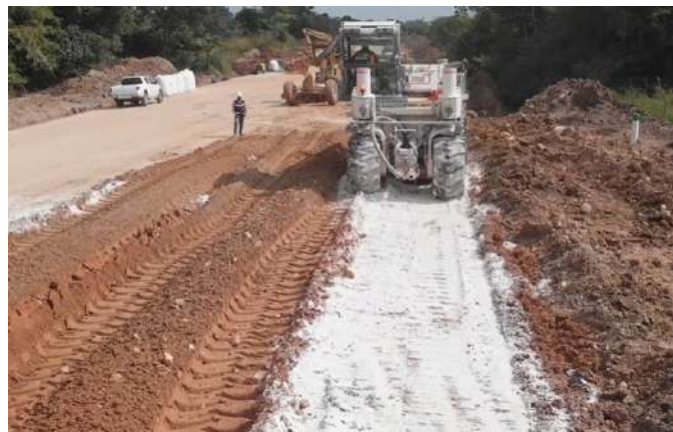
Figura 2.20 – Estabilización química (Cal)
