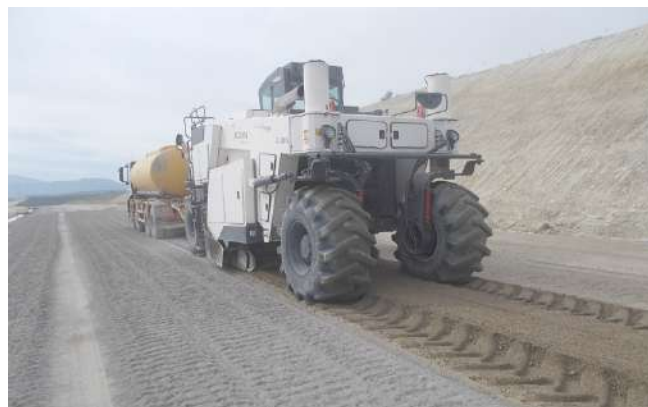
Figura 2.18 – Estabilización de suelos con cemento
