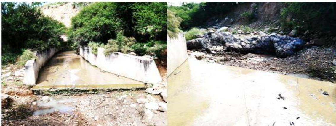
**PARTE FINAL DE LA RÁPIDA Y COLCHONETA DEFORMADA**
