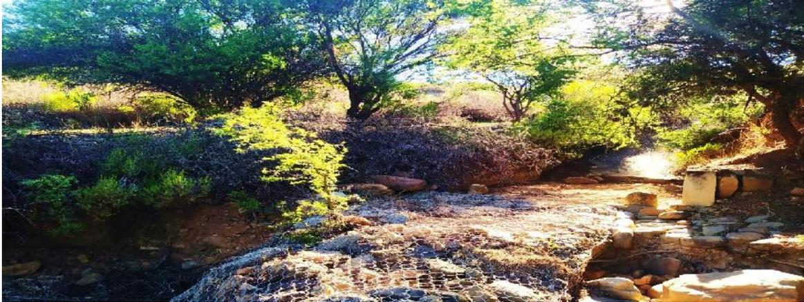
**PARTE FINAL DE LA RÁPIDA, POZO DE DISIPACIÓN SEDIMENTADO Y COLCHONETA**
