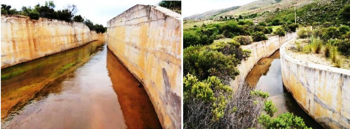
**TRANSICIÓN DE ESTRUCTURA DE DISIPACIÓN VISTA DESDE EL VERTEDERO Y CAMBIO DE DIRECCIÓN DE LA RÁPIDA CON TRES CAÍDAS**
