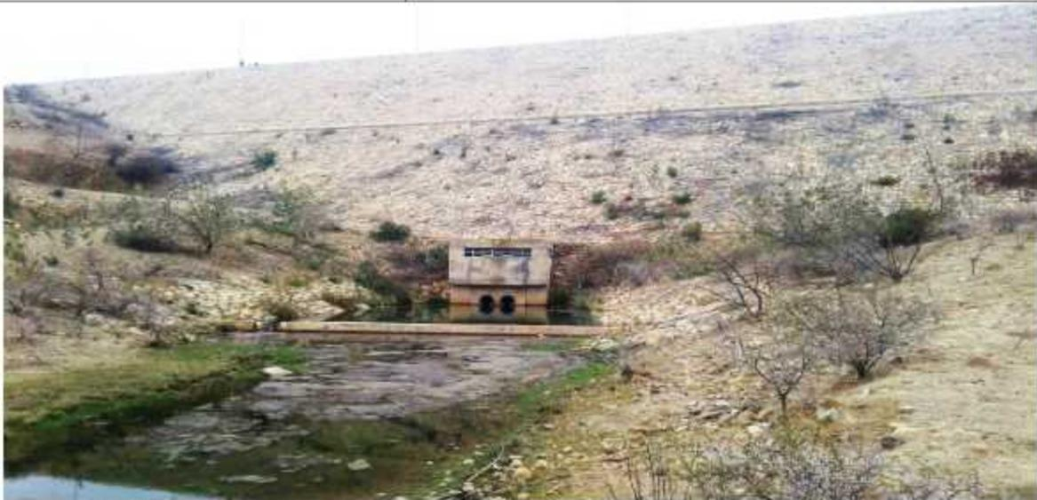
**DESFOGUE DE FONDO Y CÁMARA DE VÁLVULAS EN EL CUERPO DE LA PRESA**
