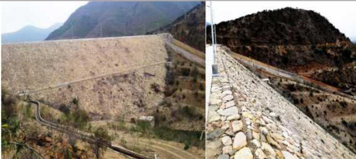
**TALUD AGUAS ABAJO CON PROTECCION DE ENROCADO**
