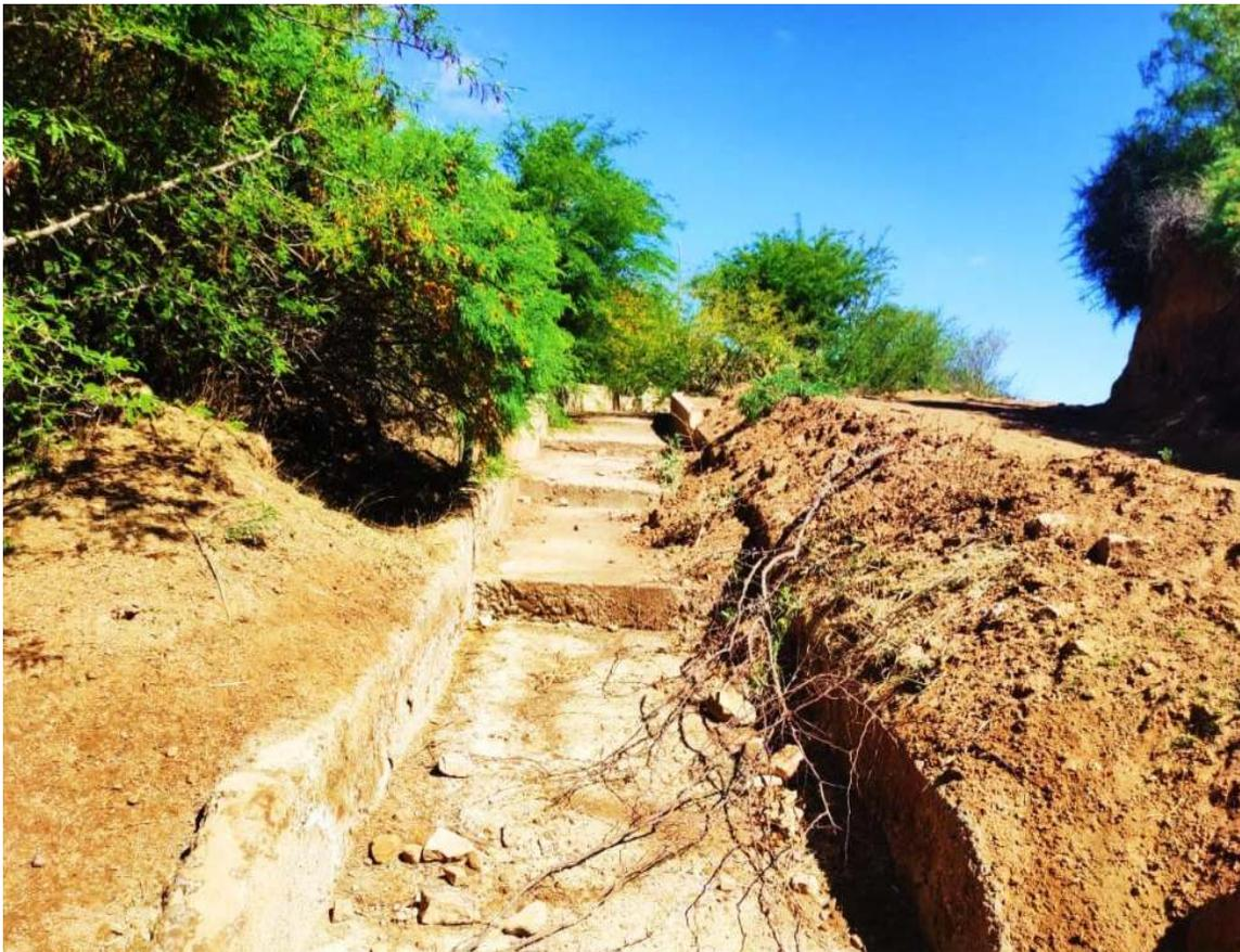
**PARTE FINAL DE LA RÁPIDA ESCALONADA AFECTADA POR DESLIZAMIENTO DEL TERRENO**
