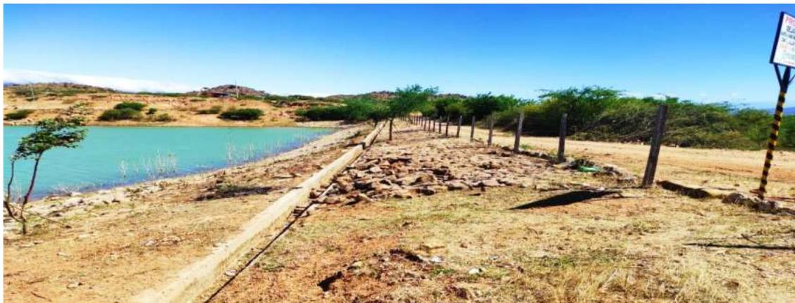
**TALUD AGUAS ARRIBA CON EL CANAL DEL SISTEMA DE MICRORIEGO LA FARELLA**
