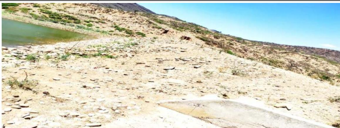
**TALUD AGUAS ARRIBA DE LA PRESA CON PROTECCION DE ENRROCADO EN DETERIORO**
