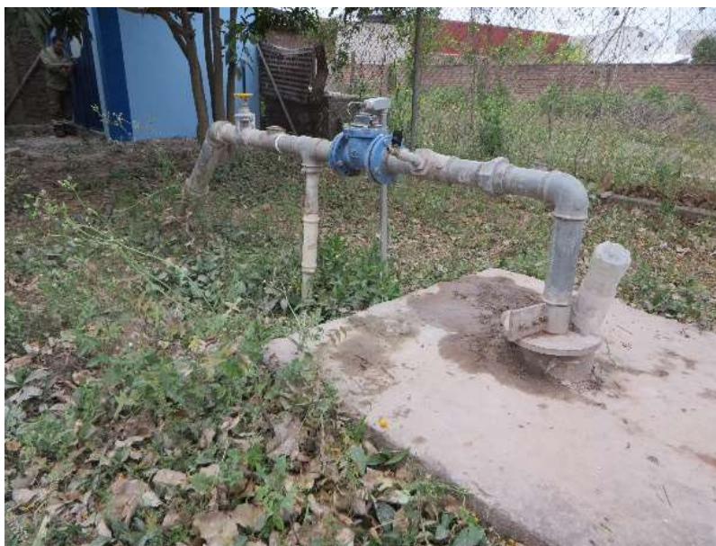
Figura 44: Registro fotográfico del Pozo YC-34
