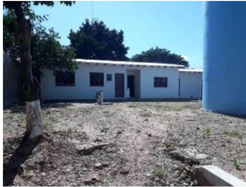
Figura 28: Registro fotográfico del Pozo N°9
