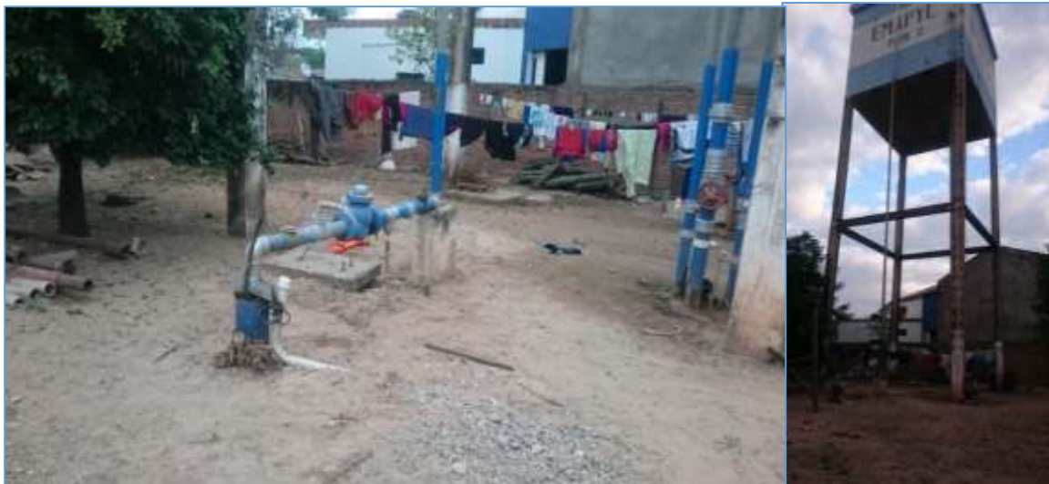
Figura 16: Registro fotográfico Pozo N°2
