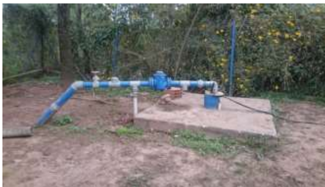
Figura 41: Registro fotográfico del Pozo YC-04
