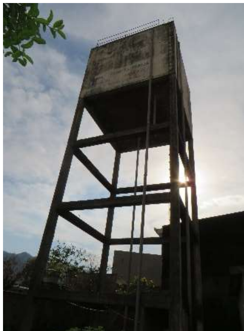
Figura 18: Registro fotográfico tanque del Pozo N°4
