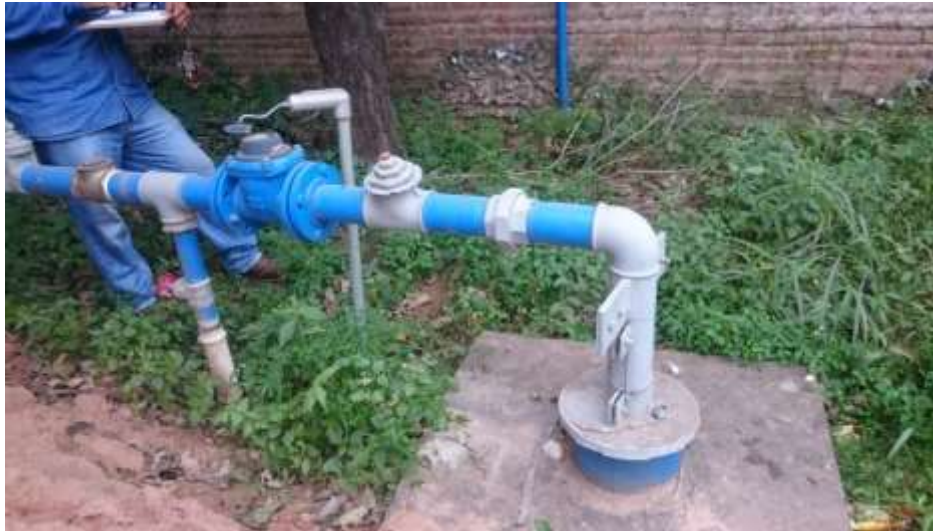
Figura 46: Registro fotográfico del Pozo YC-03
