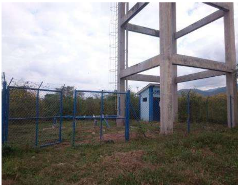
Figura 31: Registro fotográfico del Pozo Terminal
