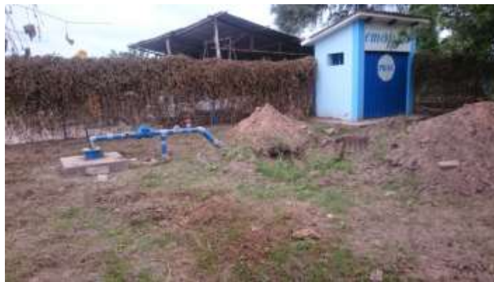
Figura 34: Cierre perimetral del Pozo YB-08
