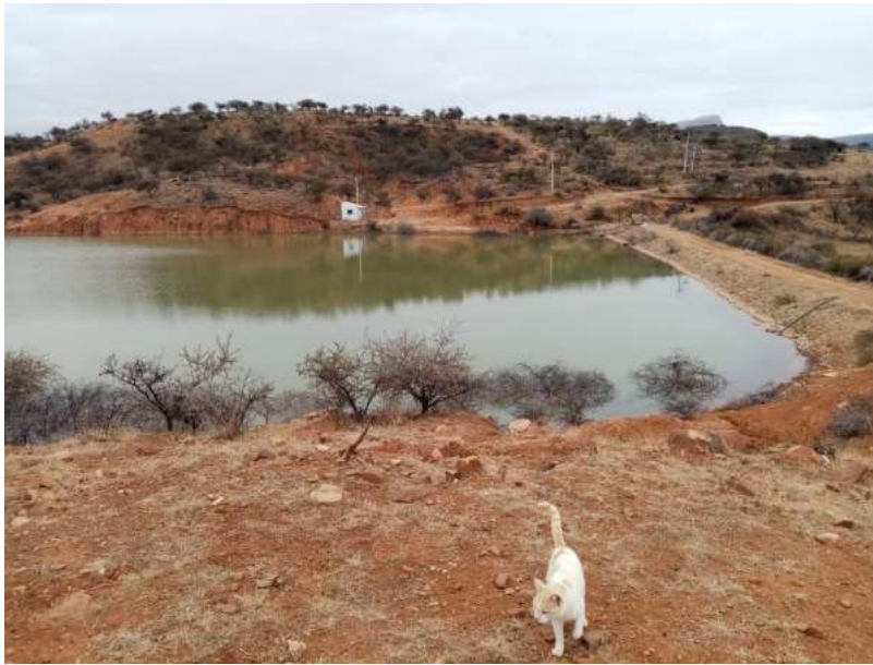
Fotografía 3 Vista Lateral Presa Colpana
