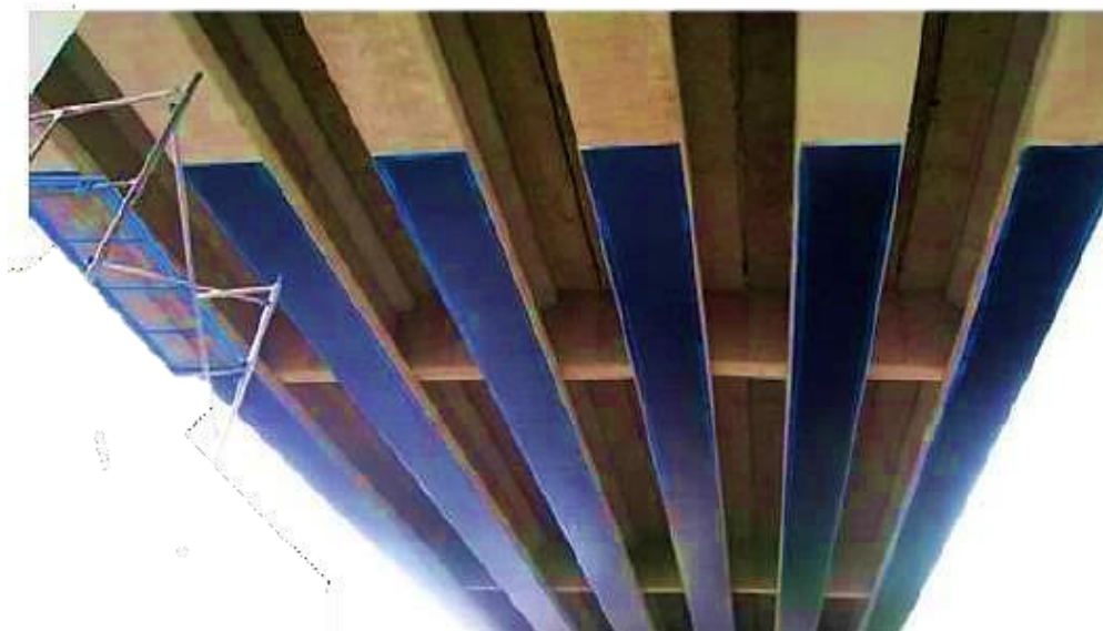
Figura 1.3. Refuerzo con fibra de carbono de un puente Fuente: Escuela técnica superior de edificación
