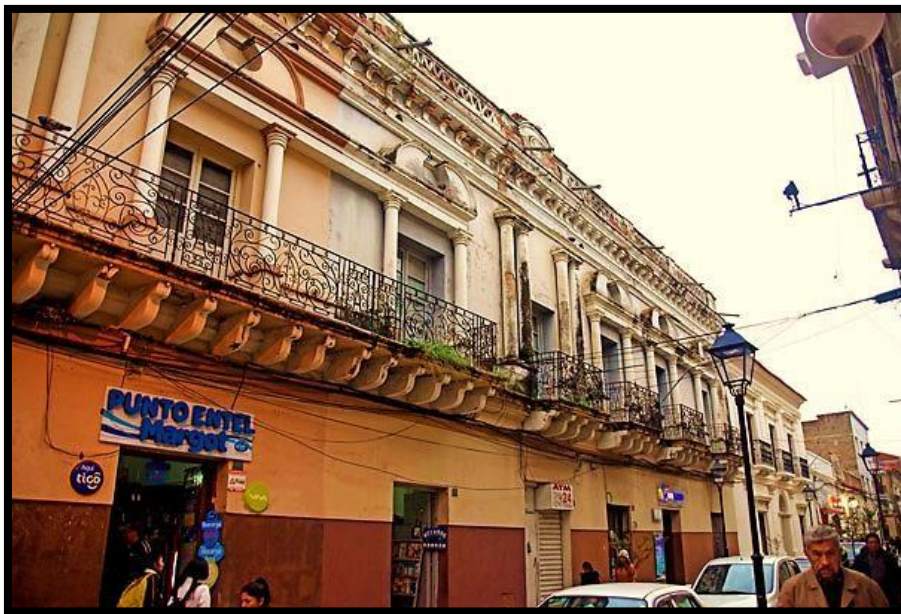
Figura 2.1: Edificio patrimonial ubicado en la calle General Trigo
