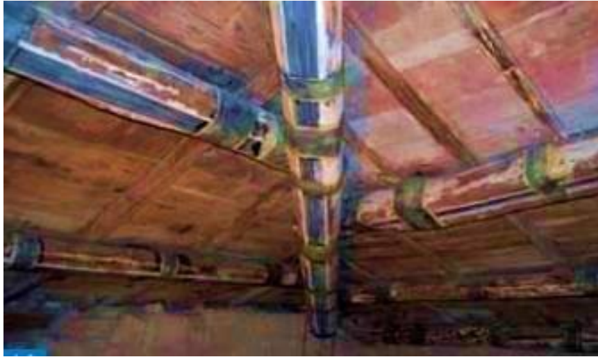
Figura 2.3. Reforzamiento del Palacio Farnecio. Fuente: Revista estudio en madera
