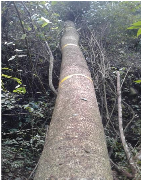
Derribe, marcado y troceado del árbol N°2
