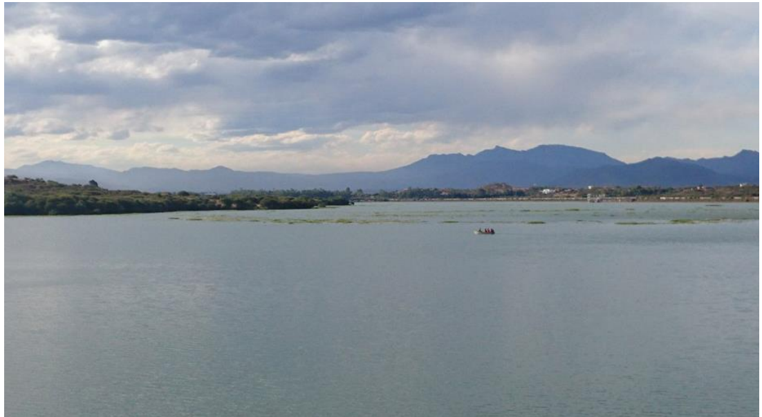
Vista parcial de la represa San Jacinto.
