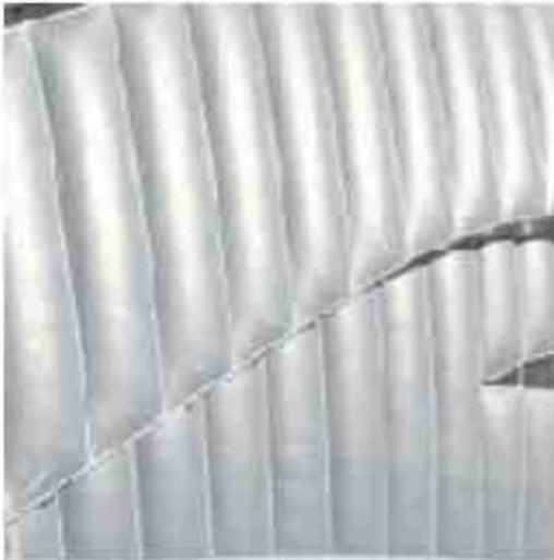
En su gran mayoría las edificaciones son transparentes ósea están recubiertas con un material transparente como es ETFE un material noble para el tipo de construcción diseñada con paneles rectangulares 5m por 12M, 15M, 20M y otras variantes en los diferentes biomas
