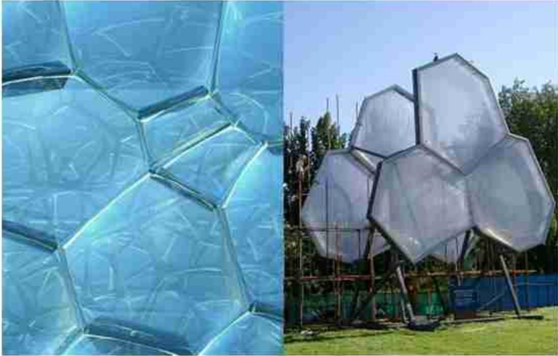
Los domos están formados por una estructura de tubos de acero galvanizado de diferentes tamaños. El equipo de Grimshaw trabajó en estrecha relación con Anthony Hunt Associates Ltd y Mero Plc para desarrollar la estructura y definir la longitud de cada sección de acero a través de modelos 3D realizados por ordenador. Esto permitió que cada sección de acero se fabricara individualmente para ser ensamblados in situ.
