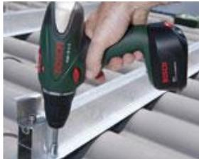
Presentamos los carriles, y los atornillamos con unos tornillos autoperforantes, a los que colocaremos unas juntas de goma para evitar que el agua filtre al interior del hogar. Los apretamos con el taladro provisto de una llave de vaso.
