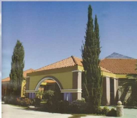
Vista del ingreso principal al edificio
