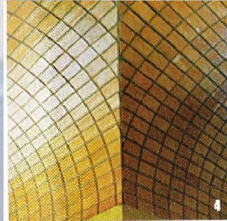
Encuentros y detalles de la bóveda de ladrillo visto
