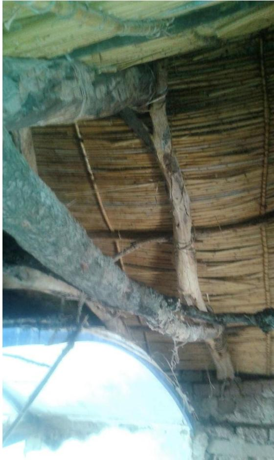
**FIGURA 32: Cercha hecha rústicamente permite la forma en bóveda del cielo falso**
