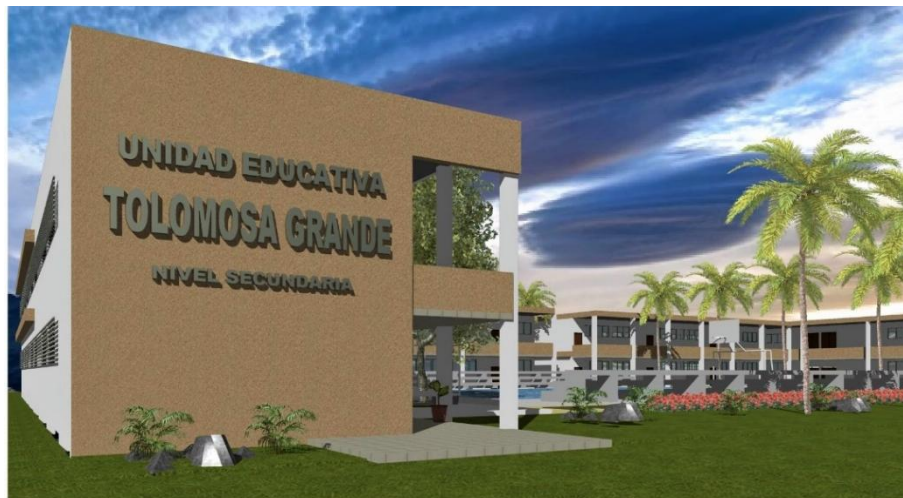
Figura 3.5 Fachada principal de la UNIDAD EDUCATIVA TOLOMOSA GRANDE
