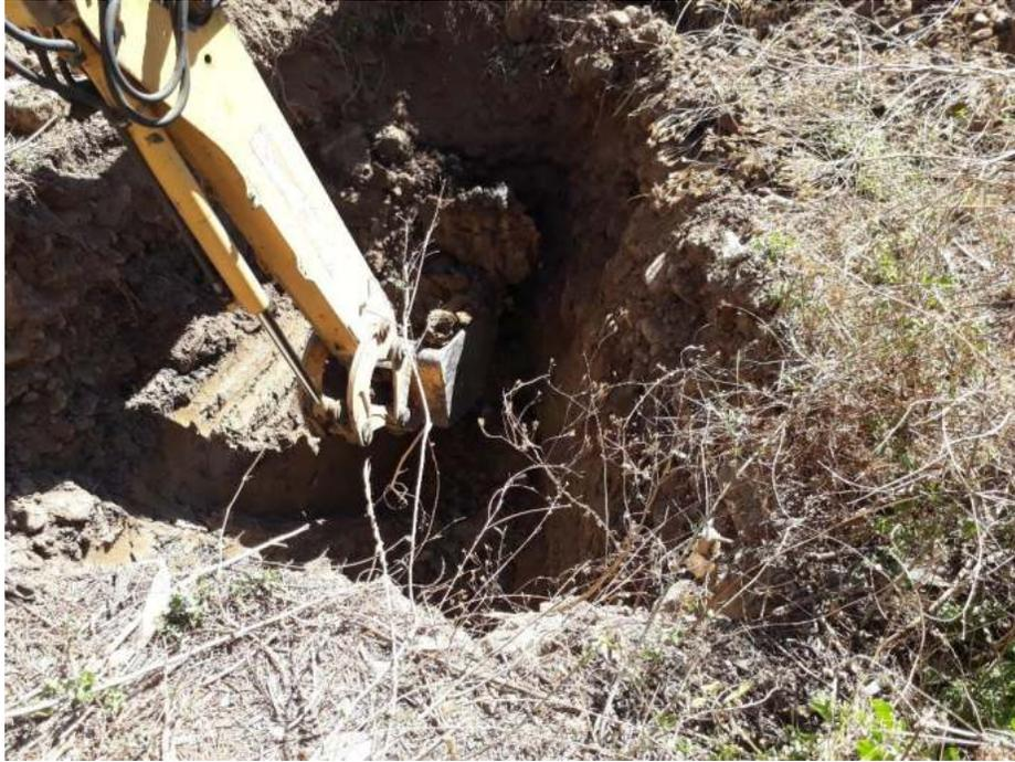
Perforación del pozo para en ensayo S.P.T.
