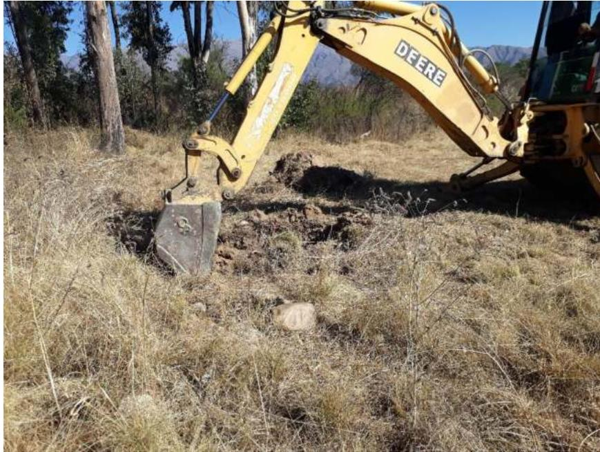
Perforación del 2<sup>do</sup> pozo a realizar el ensayo S.P.T.
