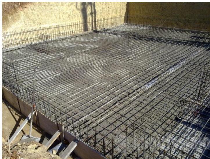
**Figura 27 Losa de Fundación**
