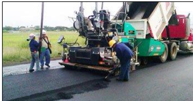
Imagen 1: Puesta en obra de la mezcla asfáltica
