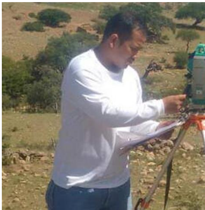
Imagen 2: Establecimiento de la poligonal de trazo
