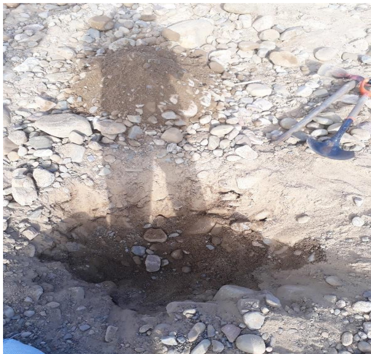
Figura 3.1 Material arenoso talud río Santa Ana.
