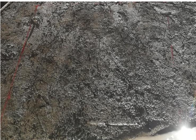
Figura 3.38. Sección 2: Monitoreo inicial Fuente: Fotografía propia
