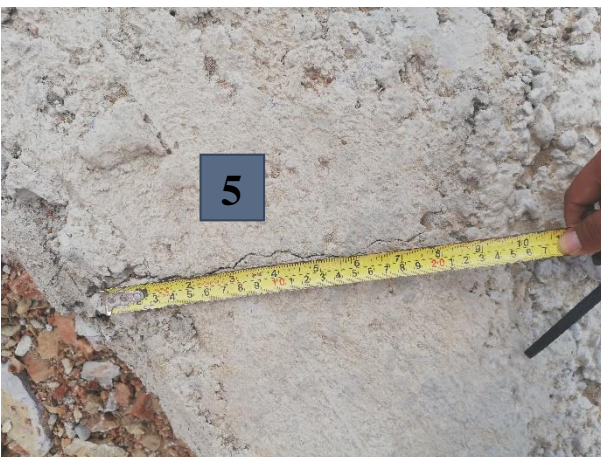
Figura 3.42. Fisura sección 1: Monitoreo 21 días Fuente: Fotografía propia
