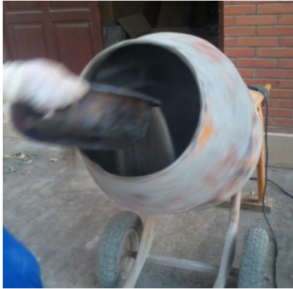
Figura 3.25. Vertido de agregado fino en la mezcladora Fuente: Fotografía propia
