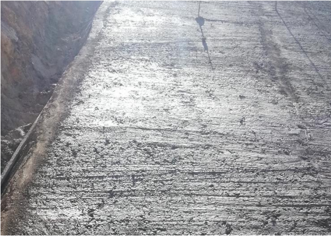
Figura 3.37. Sección 1: Monitoreo inicial Fuente: Fotografía propia
