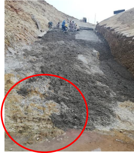
Figura 3.34. Vaciado piso de nivelación Fuente: Fotografía propia
