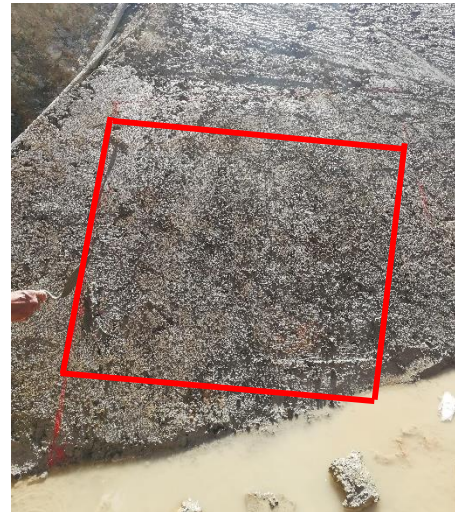
Figura 3.35. Piso de nivelación, hormigón con vinaza Fuente: Fotografía propia
