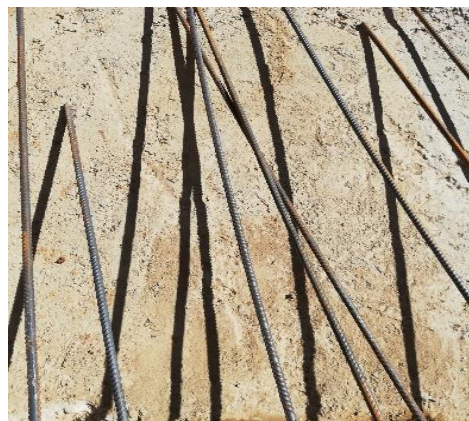
Figura 3.47. Sección 2: sin fisuras 35 días Fuente: Fotografía propia
