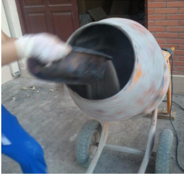
**Figura E.3.** Vertido de agregado fino en la mezcladora
