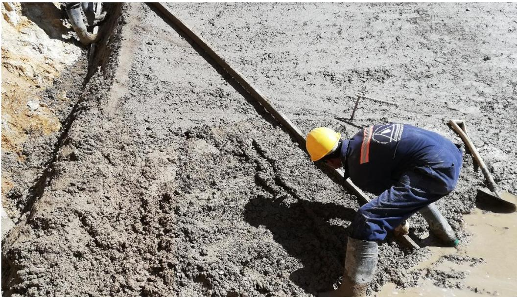
*Figura E.38. Enrasado nivel de hormigón
