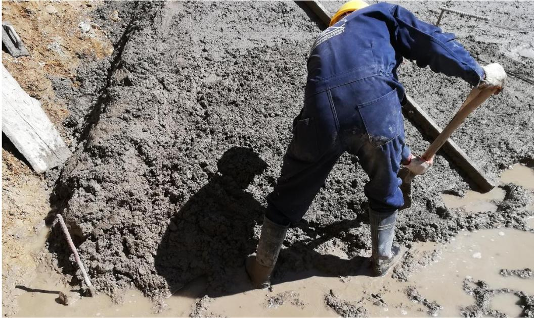
*Figura E.37. Vaciado de hormigón inclusión de vinaza al 30%
