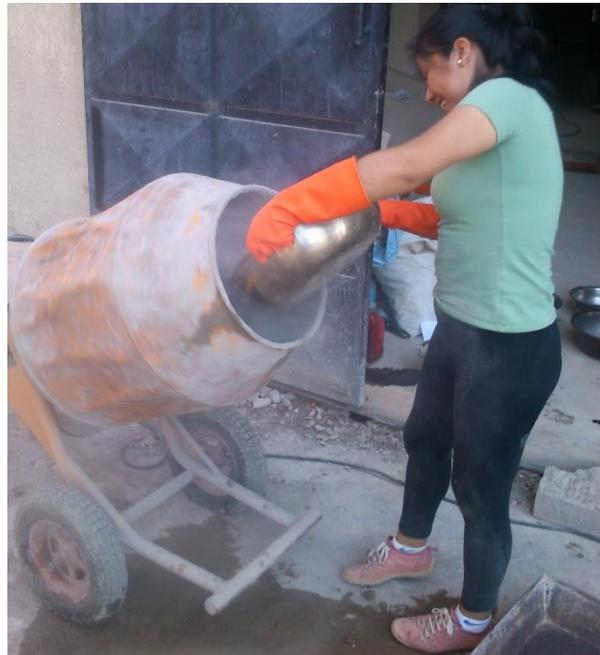
**Figura E.4.** Vertido de cemento en la mezcladora
