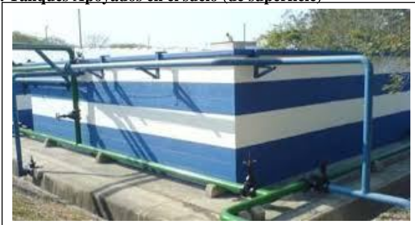
Figura 2.9. Tanques Apoyados en el suelo (de superficie)
