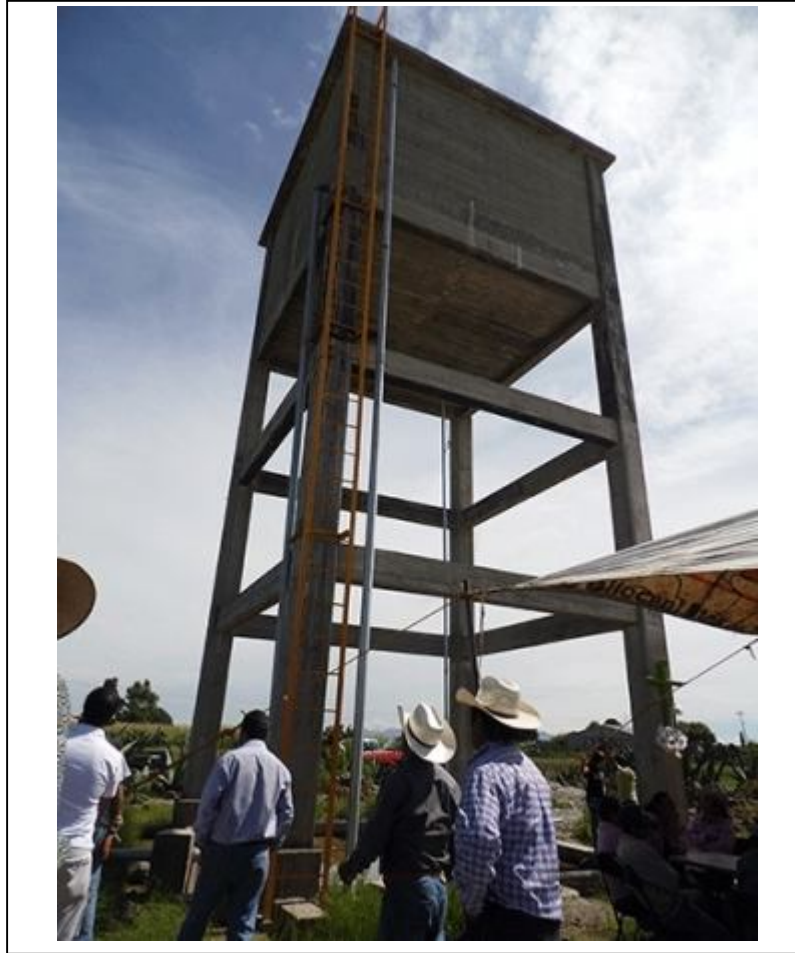
Figura 2.10. Tanques Elevados (por encima del nivel del techo)
