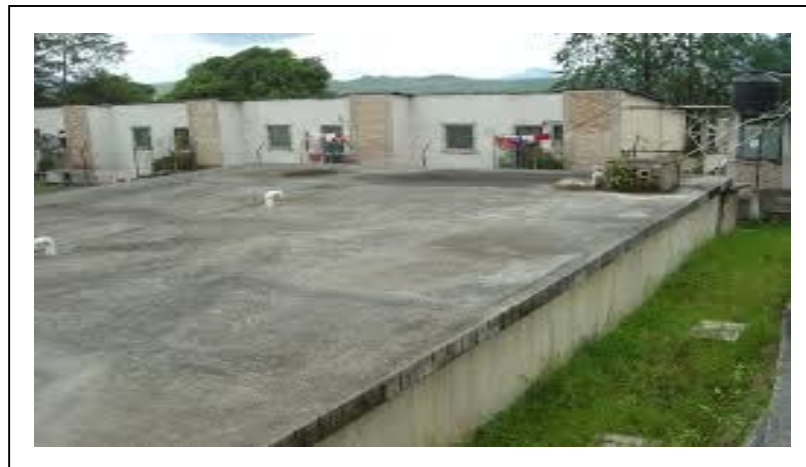
Figura 2.8 Tanques semienterrados
