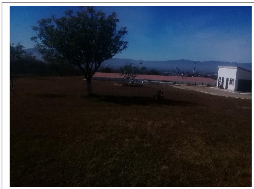
Tanque de almacenamiento de la Tablada
