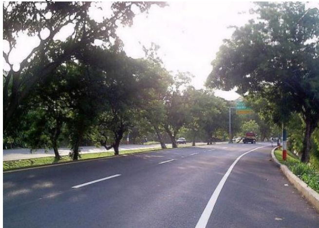
Figura 2.5 Pavimento de concreto asfáltico.
