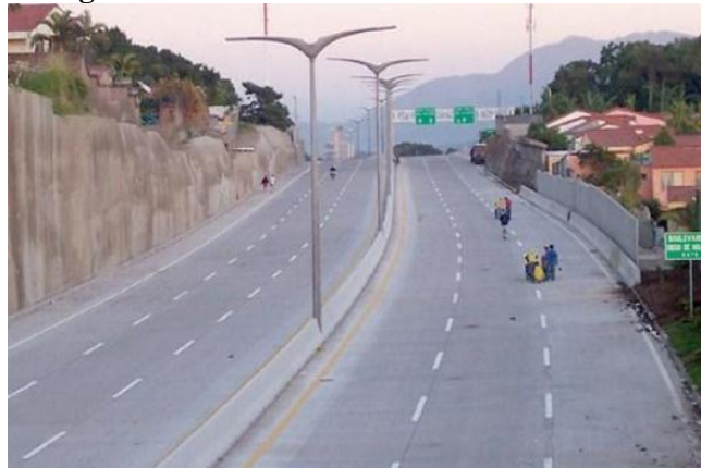
Figura 2.4 Pavimento de concreto hidráulico.
