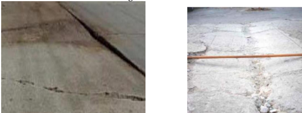
Figura 2.32 Hundimiento
