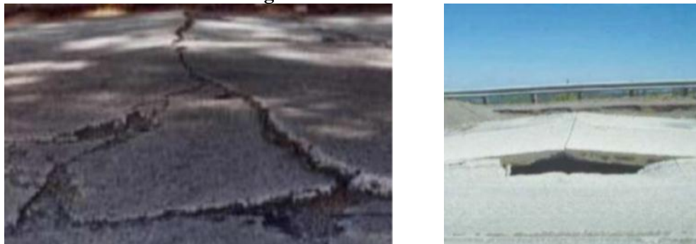
Figura 2.30 Levantamiento de losas
