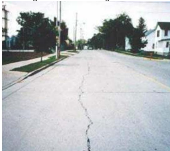
Figura 2.25 Fisura longitudinal
