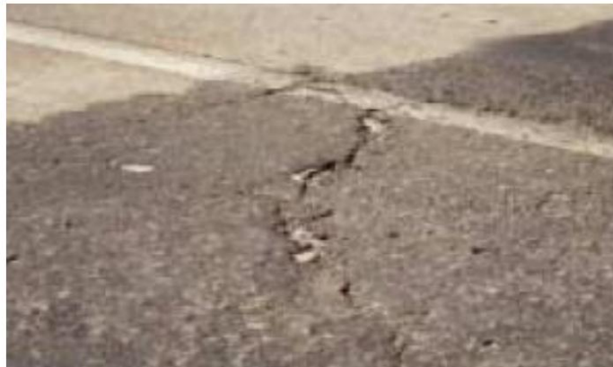
Figura 2.29 fisuras inducidas
