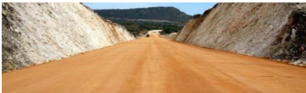
Figura 2.3 Subrasante de terreno
