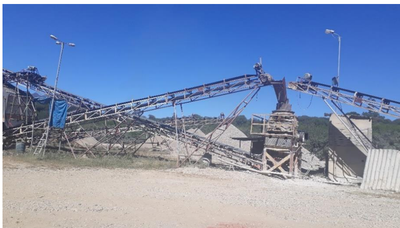
Fotografía 3.8: Cinta transportadora del agregado
