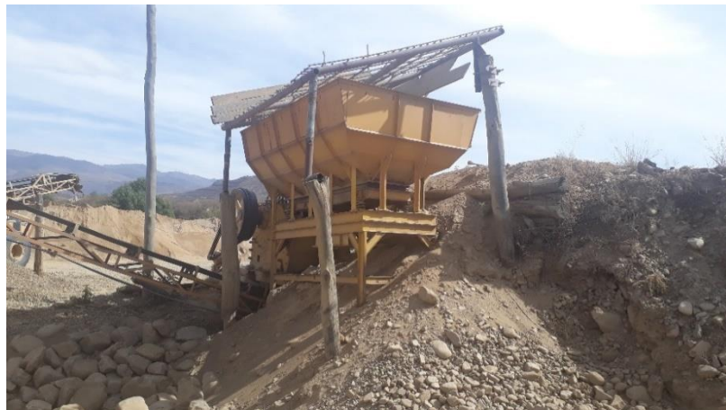
Fotografía 3.1: Trituradora de agregado
