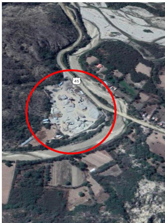
Figura 3.3: Vista satelital de la ubicación de la planta de agregados SEDECA
