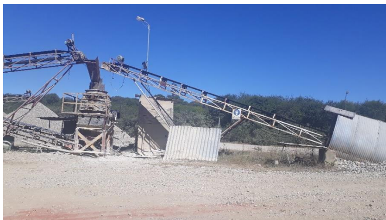
Fotografía 3.10: Almacenamiento del material triturado
