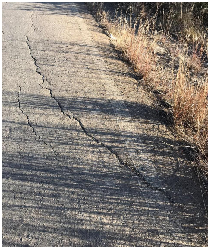
Fisura parabólica
