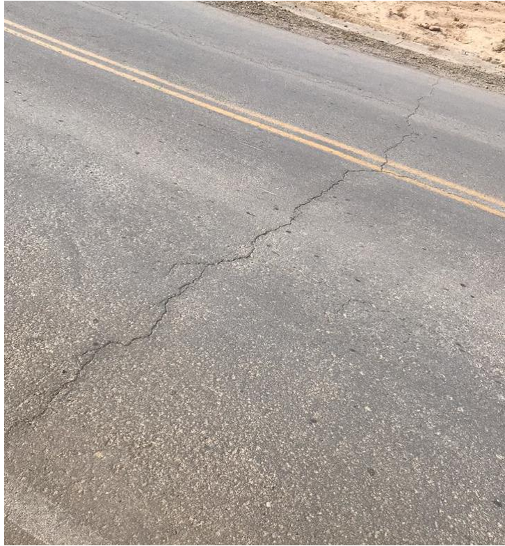
Fisura transversal
