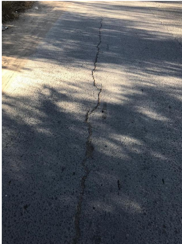
Fisura longitudinal
