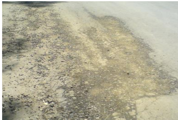
Figura 19. Disgregación
