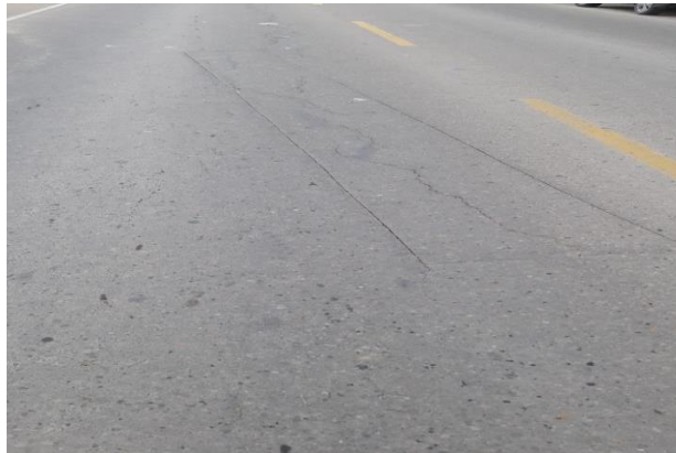
Figura 11. Bacheo o zanjas reparadas (Parcheo)
