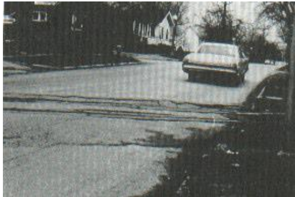
Figura 14. Cruce de sumideros y rieles
