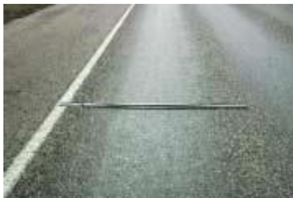
Figura 15. Ahuellamiento
