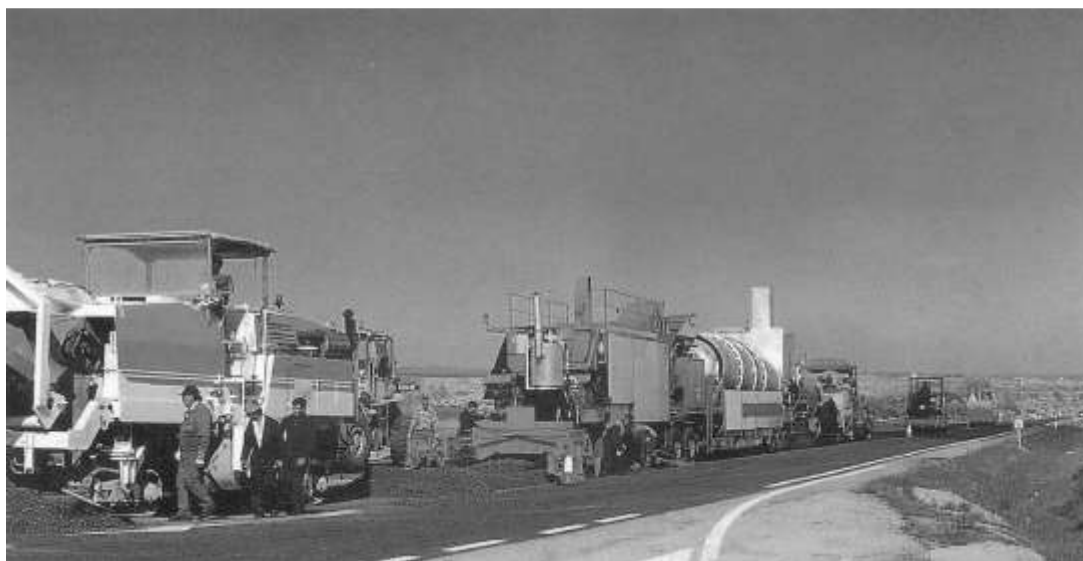
Imagen 2.4:1. Maquinaria de tratamiento en caliente in situ
