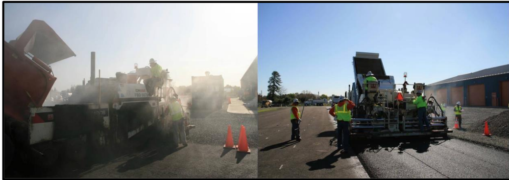
Figura 7. Colocación de mezcla asfáltica en caliente y mezcla asfáltica tibia.
