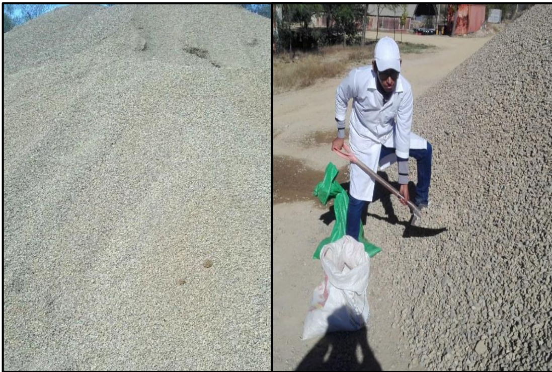
Figura 54. Acopio de la gravilla.
