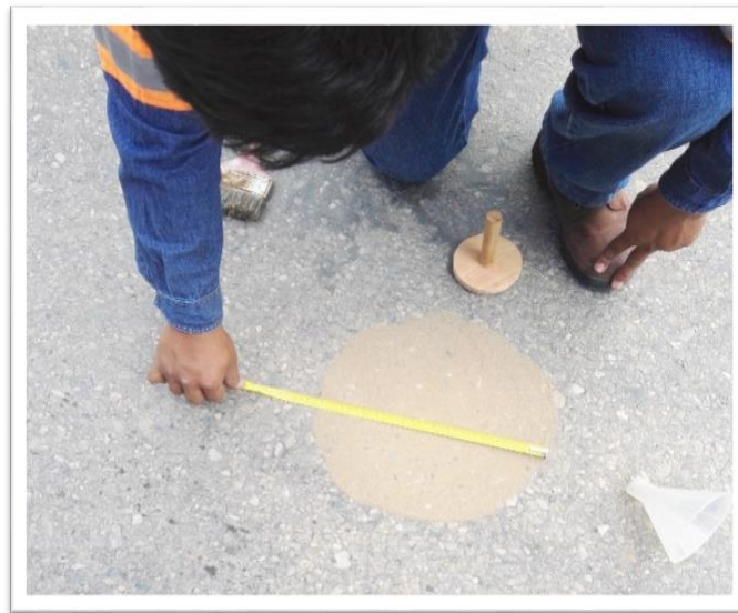
Figura 2.11. Medición de la textura superficial
