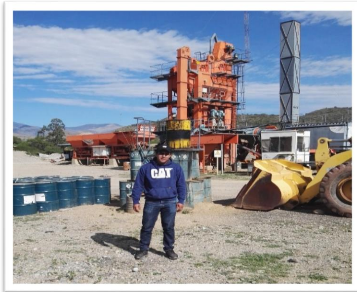
Figura B.2. Planta chancadora Servicio Departamental de Caminos (SE.DE.CA.)
