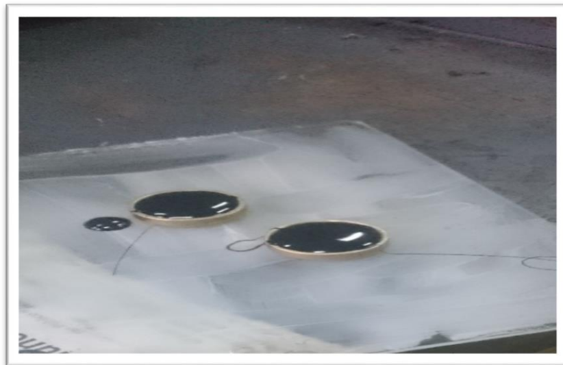
Figura C.17. Colocado del cemento asfáltico en los anillos
