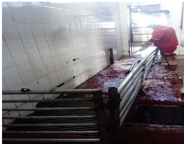
Figura 21. Canal de recolección de aguas residuales procedentes de Porcinos.
