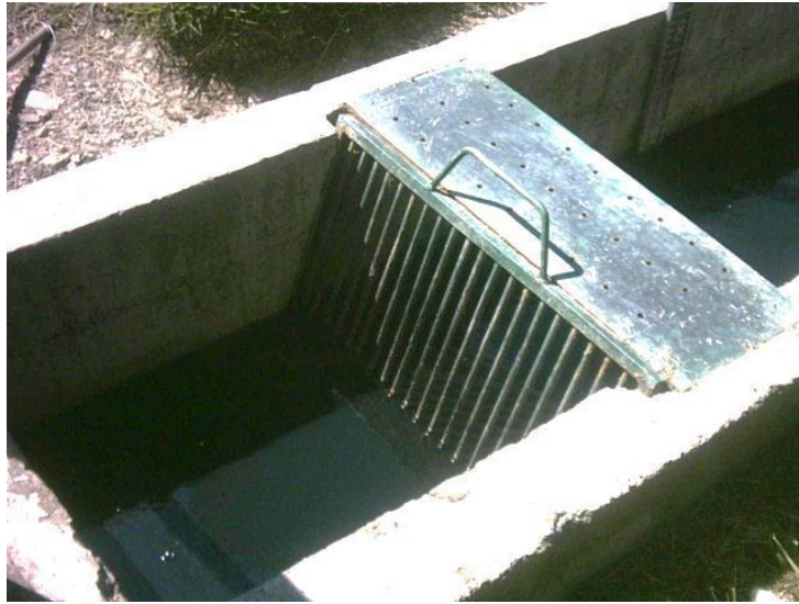
Figura 11. Rejilla media con lámina perforada para escurrimiento del material extraído
