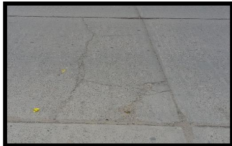
UM-14 (Prog. 0+643,614 a Prog. 0+665,538) Losa dividida
