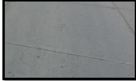
UM-21 (Prog. 0+982,210 a Prog. 1+6,214) Pulimiento de agregados
