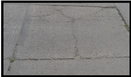
UM-7 (Prog. 0+305,416 a Prog. 0+329,124) Losa dividida
