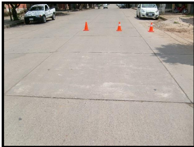
Fotografía 12 - Delimitación de muestras mediante conos reflectores Calle Tarija UM-5 (Prog. 0+210 a Prog. 0+234)
