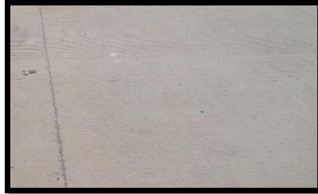
UM-5 (Prog. 0+95,204 a Prog. 0+119,005) Pulimiento de agregados
