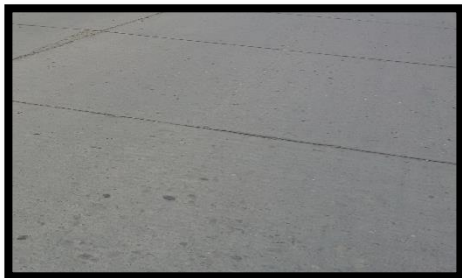
UM-27 (Prog. 1+270,209 a Prog. 1+294,501) Pulimiento de agregados
