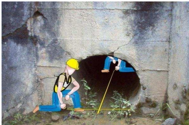
Figura 2.28 Obstrucción de alcantarilla
