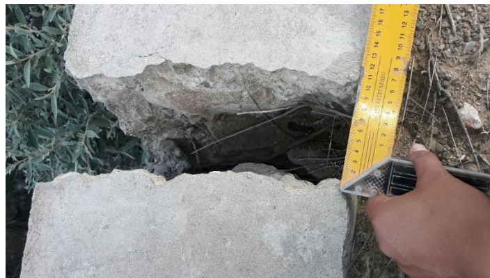
Figura 3.10 Medición de una grieta
