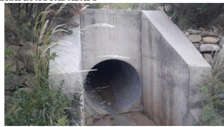
FOTOGRAFIA AGUAS ABAJO
