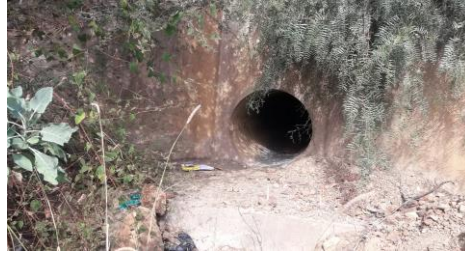
FOTOGRAFIA AGUAS ABAJO
