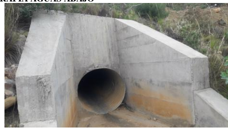
FOTOGRAFIA AGUAS ABAJO
