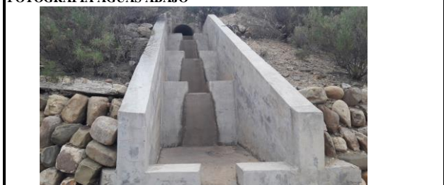
FOTOGRAFIA AGUAS ABAJO
