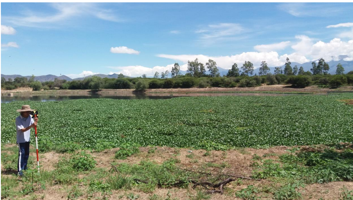
Fotografía N° 2: Disparo de la estación total hacia el prisma en el replanteo de la laguna anaeróbica 1
