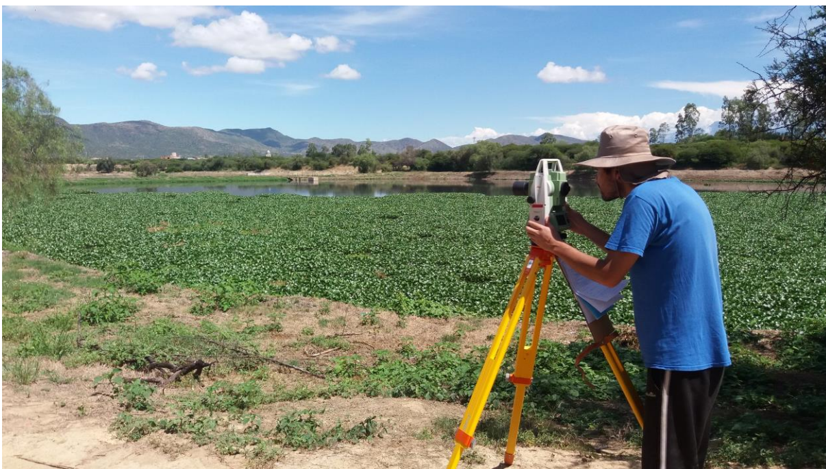
Fotografía N° 2: Disparo de la estación total hacia el prisma en el replanteo de la laguna anaeróbica 1
