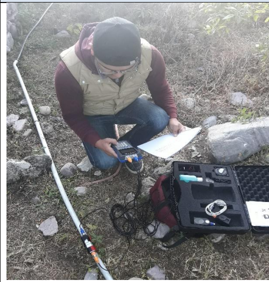
Fotografía No 9: Medicion Caudales Tub. 1/2" PERDIDAS DE AGUA
