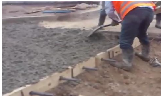
Figura 2.20 Trabajos en junta transversal de construcción
