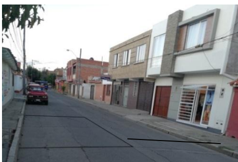
Figura 2.23 Junta transversal de construcción
