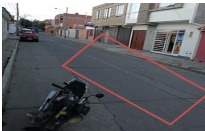
Figura 2.26 Junta longitudinal de construcción en la calle Padilla
