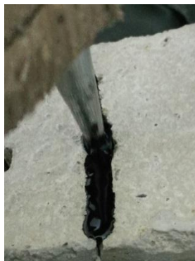
Figura 3.29 Colocado del sellador a grietas y fisuras
