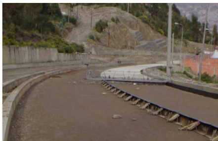
Figura 2.22. Junta transversal de construcción
