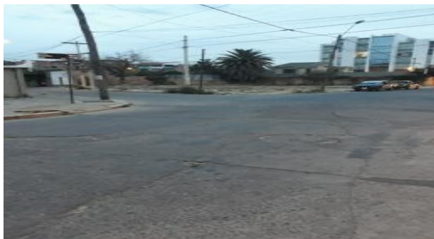
Figura 2.36 Fisuramiento de losa
