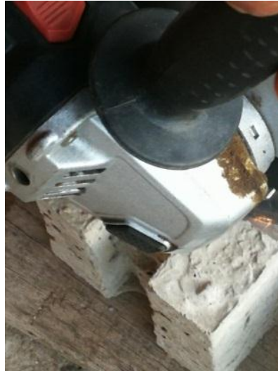
Figura 3.25 Aserrado en la superficie de la grieta
