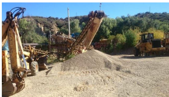
Figura 3.2 Material acopiado de la gravilla
