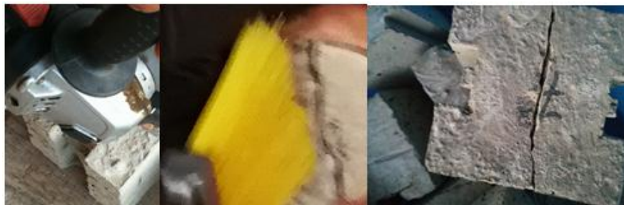
Figura 3.26 Proceso de preparación de grietas y fisuras
