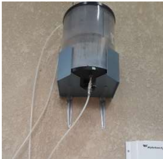
Figura 2.29. Tanque de desaireación de agua
