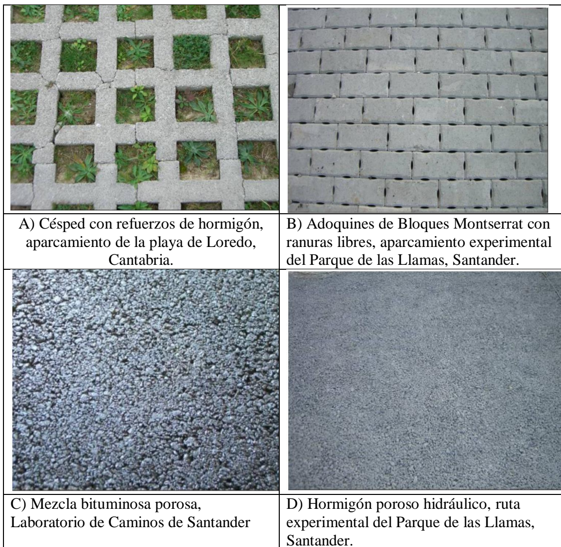
Imágen 2. 3 Clasificación de pavimentos permeable
