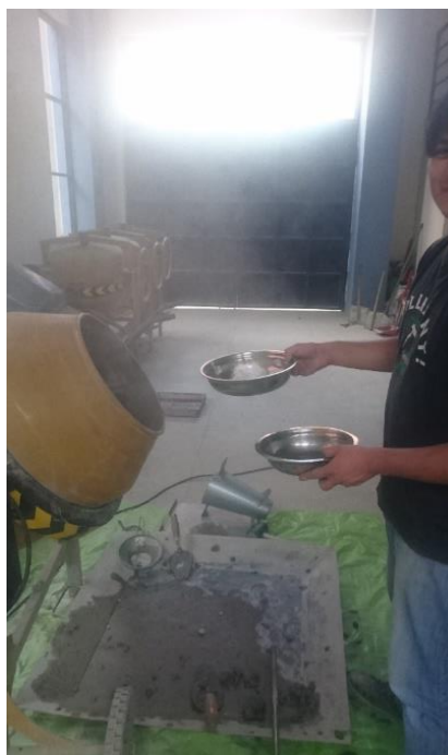
Imagen 3. 17 Dosificación en la mezcladora
