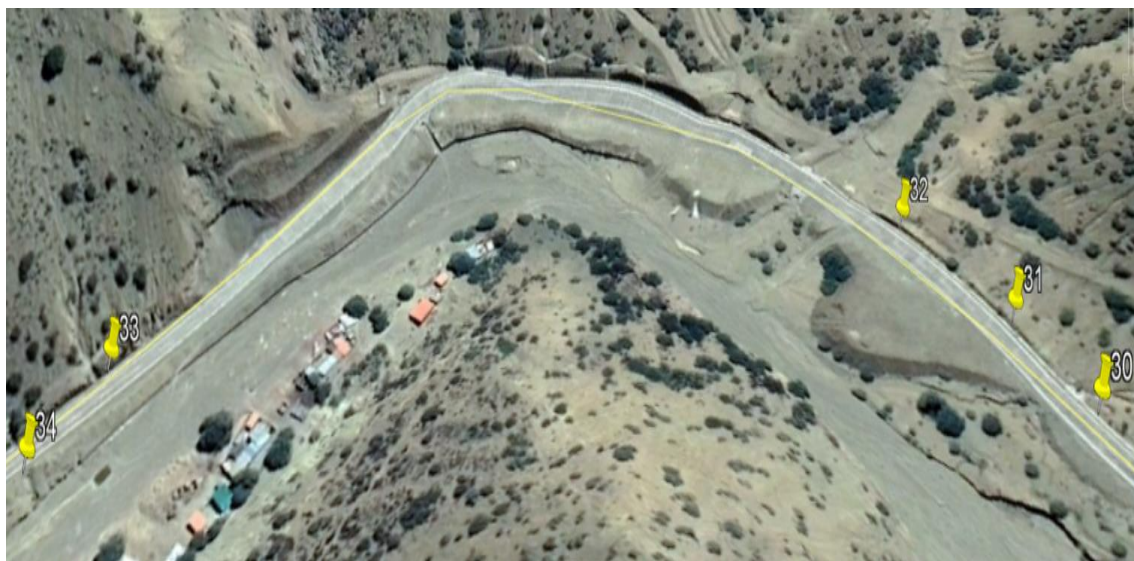
Figura N° 52. Vista satelital de los dispositivos de control de tránsito en el TCA 4
