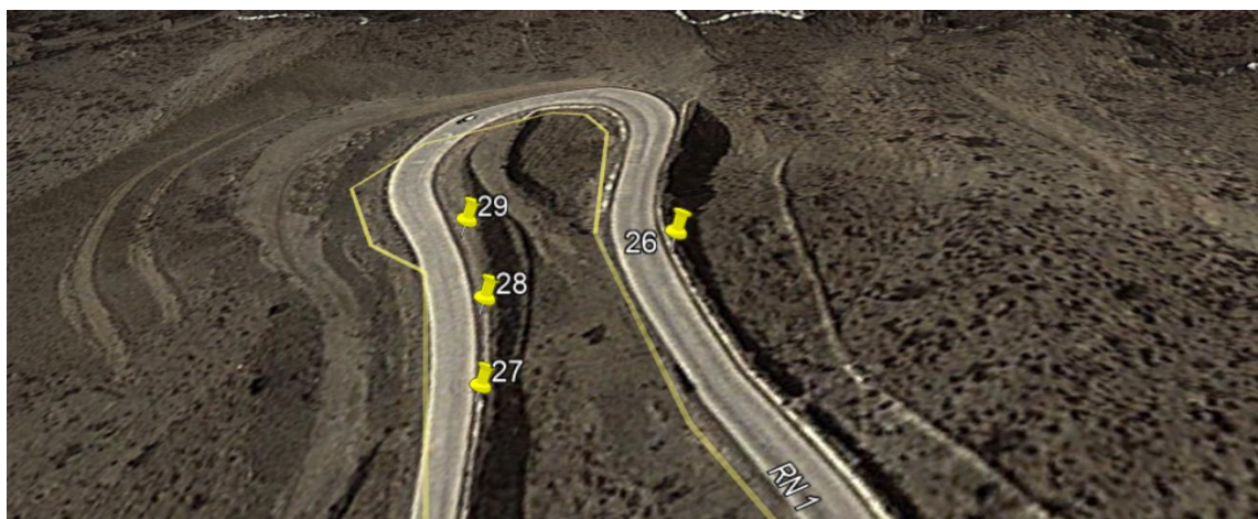
Figura N° 47. Vista satelital de los dispositivos de control de tránsito en el TCA 3
