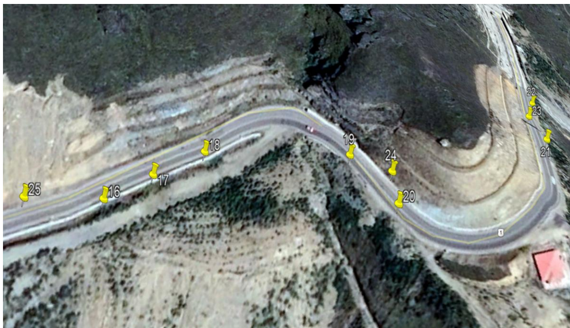
Figura N° 41. Vista satelital de los dispositivos de control de tránsito en el TCA 2
