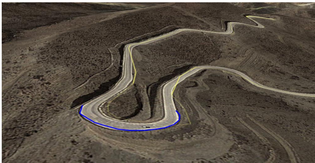
Figura N° 49. Vista satelital del Flexo-beam en el TCA 3
