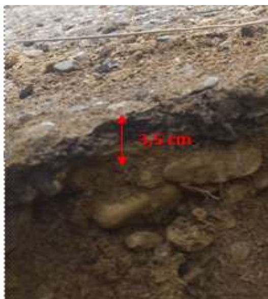
Figura 3.3: Espesor de la capa de rodadura
