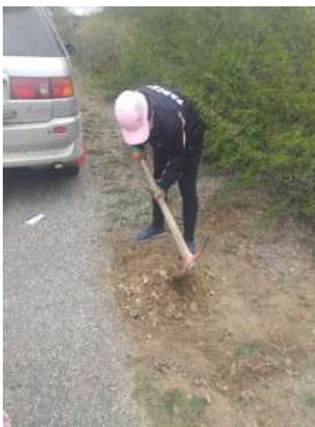
Figura 3.4: Extracción de la subrasante mejorada
