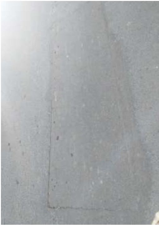
Baches y zanjas reparadas
