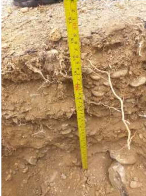
Paquete Estructural progresiva 1+300
