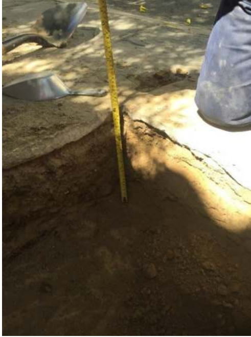
Área de Trabajo preparación de terreno, para Capa Sub base y Capa Base.
