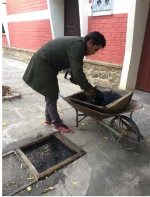
Colocado de la carpeta asfáltica en área de trabajo.
