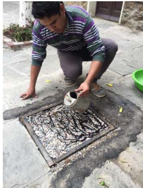
Colocado de la segunda tasa de riego de emulsión asfáltica
