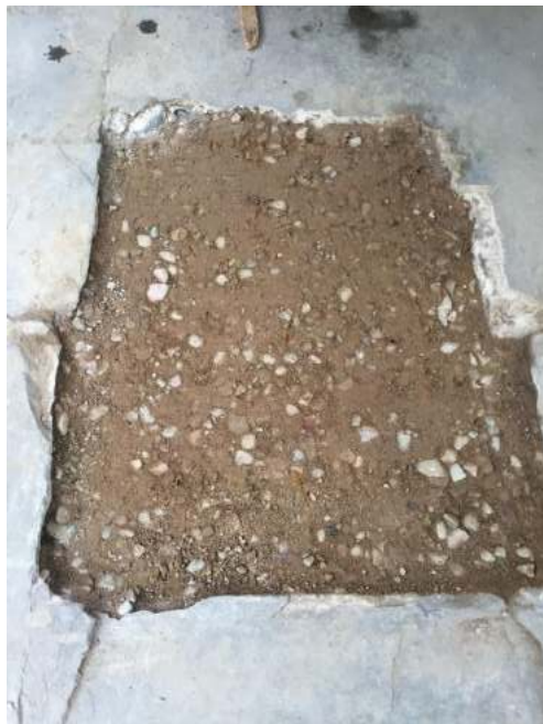
Preparación del área de trabajo para el doble tratamiento triple.
