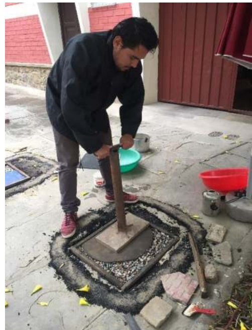
Compactado de la primera capa, con una goma para no pulverizar el agregado pétreo tipo "B"
