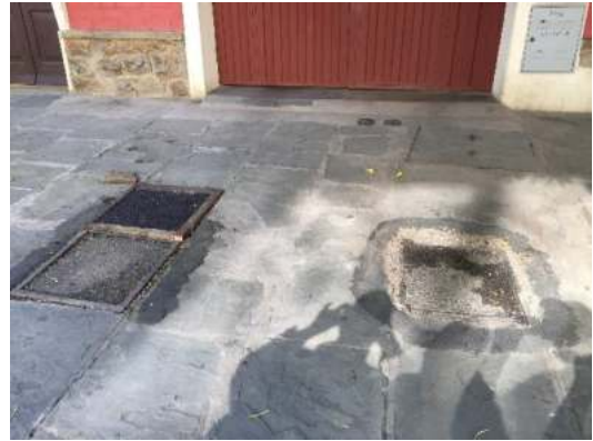
Área de trabajo terminada.
