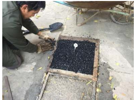
Control de temperatura para compactar.
