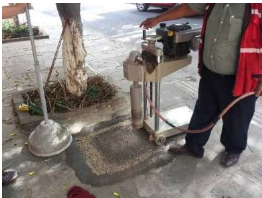
Extracción de núcleos del doble tratamiento superficial triple.
