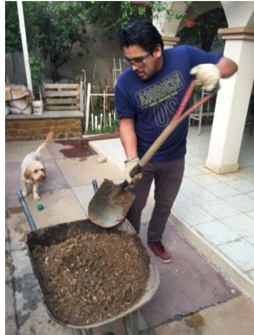
Muestra de Capa base con humedad optima, para colocar en área de trabajo.
