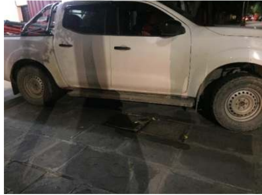
Paso de vehículos para simular el tráfico mediano que pasaría sobre el área de trabajo.
