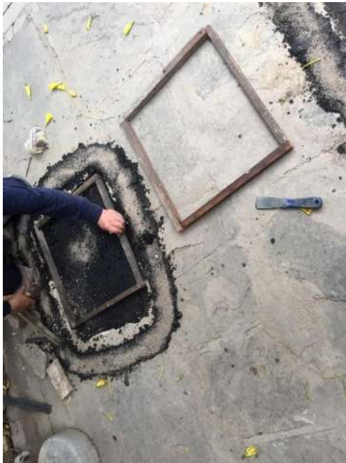
Colocado de marcos, para encofrar el agregado pétreo.
