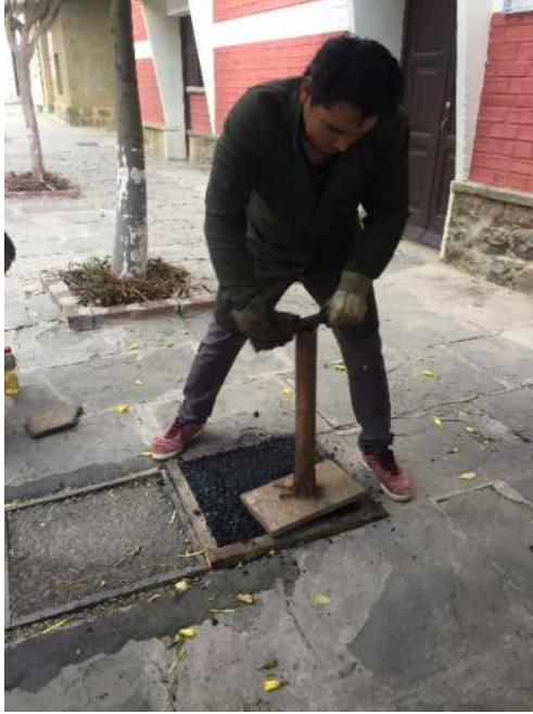
Compactado de la carpeta asfáltica.
