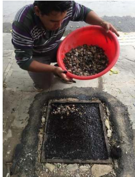
Colocado de agregado pétreo tipo "B"
