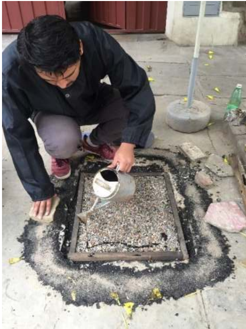
Colocado de la segunda tasa de riego.
