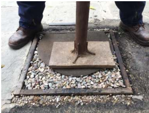
Reacomodo de las partículas con un compactador mecánico y una goma para no dañar el agregado.
