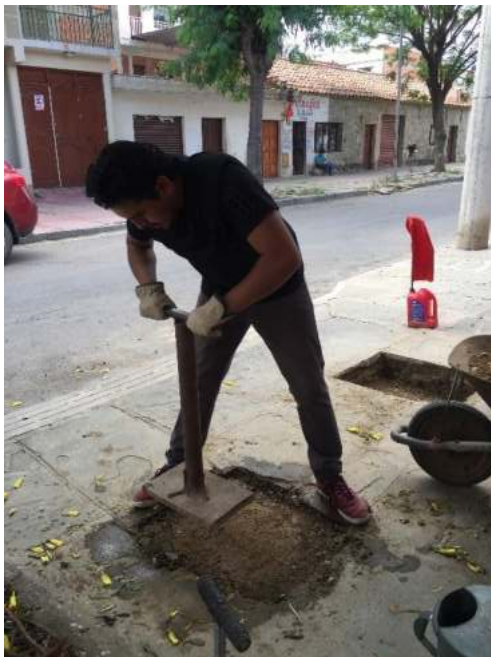
Compactación de Capa Base en área de trabajo con compactador mecánico.
