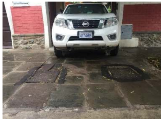
Reacomodo de las partículas, pasando vehículos sobre el tratamiento bituminoso.
