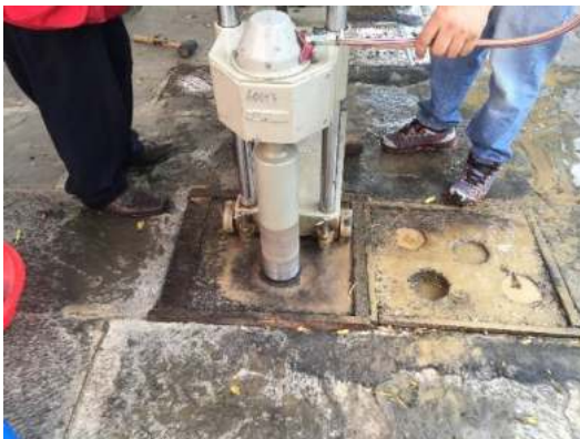
Extracción de núcleos de la carpeta asfáltica.
