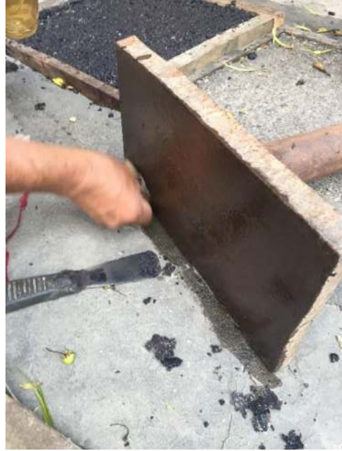
Colocado de Kerosene en la base del compactador mecánica para que no se pegue.
