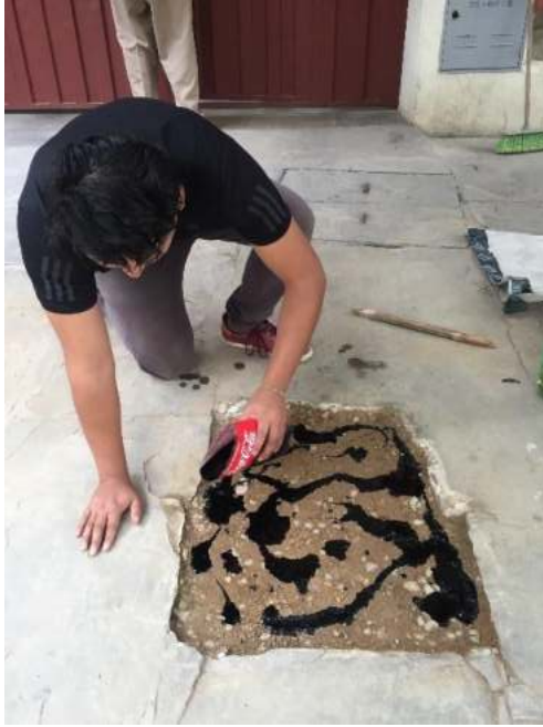
Colocado de Riego de liga un día antes de colocar el tratamiento superficial.
