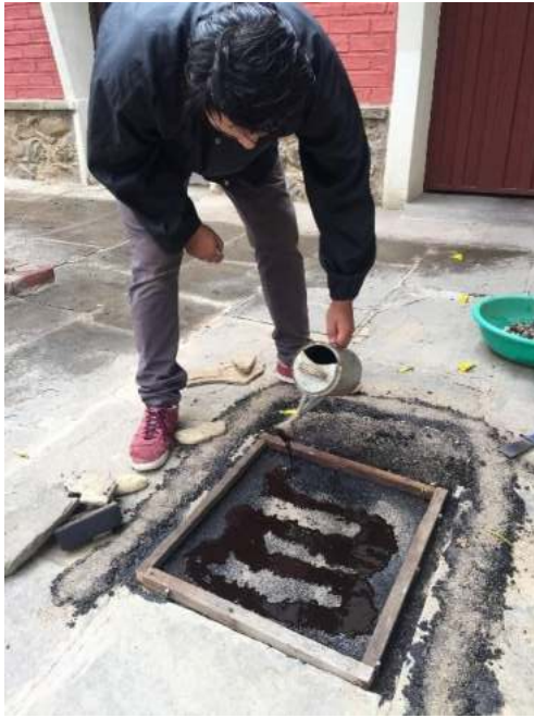
Colocando la primera tasa de riego de la emulsión asfáltica.
