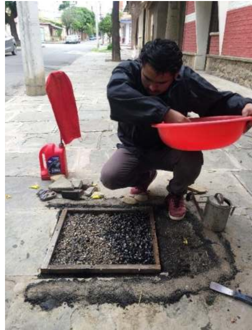
Colocado del agregado pétreo tipo "E", la tercera capa de agregado pétreo.
