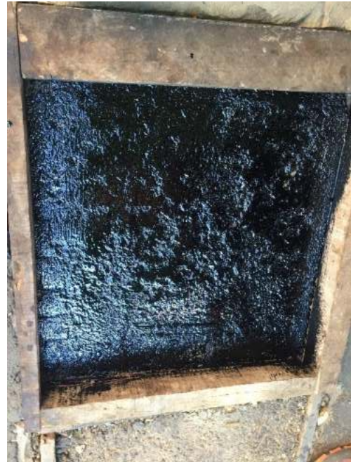
Riego de liga. RC 70 (asfalto diluido de curado rápido, 63% de asfalto)
