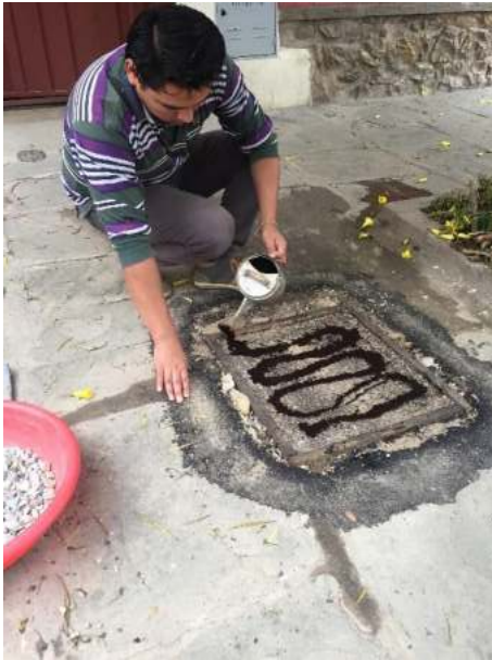
Colocado de la primera tasa de riego del segundo tratamiento bituminoso triple.
