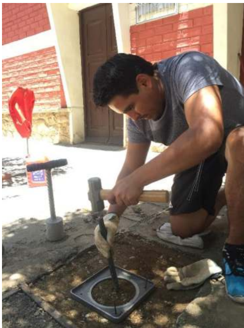
Ensayo de Densidad in situ para la Capa Base.
