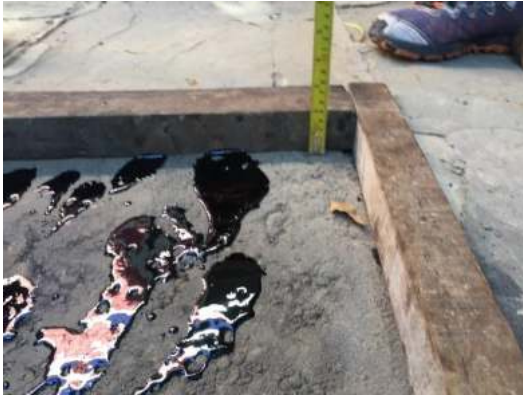
Altura de la mezcla asfáltica a conseguir 5cm.
