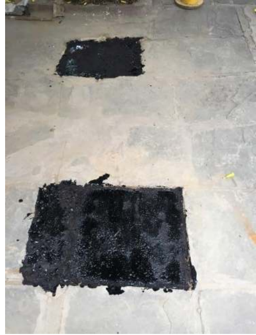
Áreas de trabajo con riego de liga.
