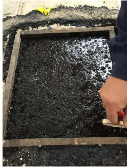
Esparcido uniformemente la tasa de riego.
