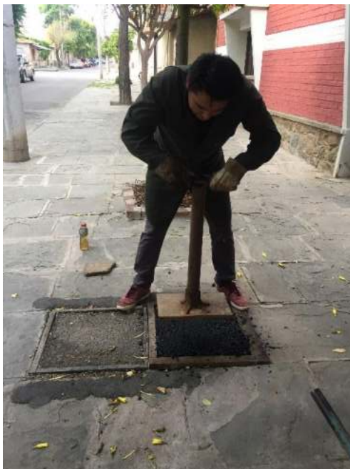
Compactado de la carpeta asfáltica.
