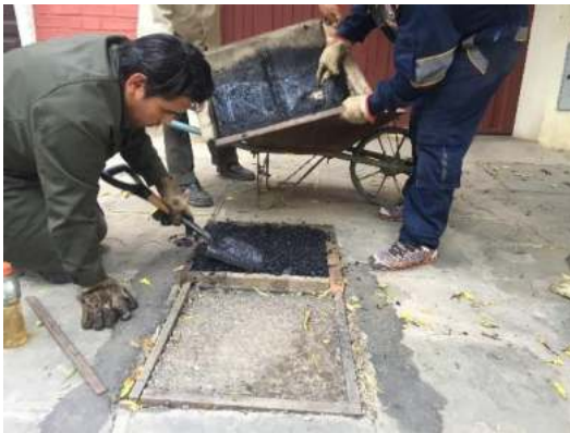
Esparcido de la carpeta asfáltica.
