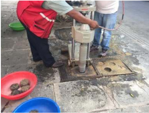
Extracción de núcleos de la carpeta asfáltica.
