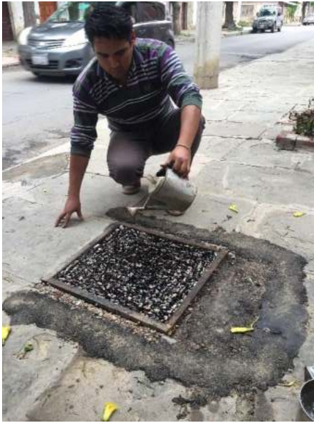
Colocado de emulsión asfáltica que corresponde al tercer riego.
