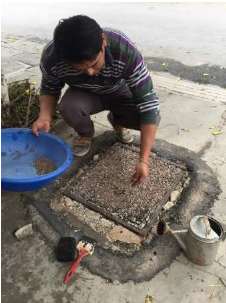
Esparcido de las partículas sobre el área de trabajo.
