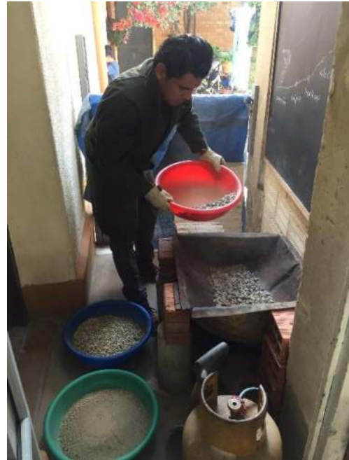
Calentado de agregado pétreo en una bandeja.
