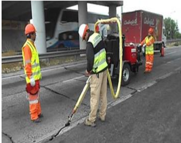
Figura 2.10 Sello de juntas con maquinaria.
