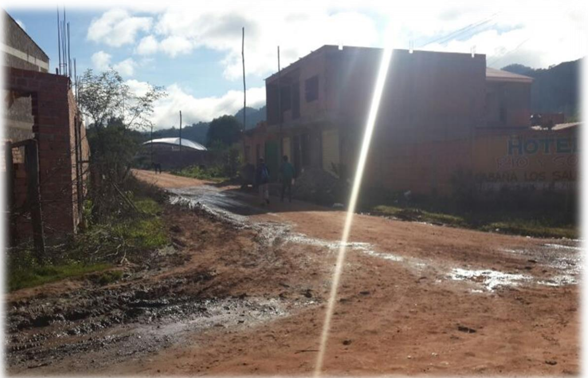
Figura 8. Calle de tierra sin acceso por falta de alcantarillado pluvial.
