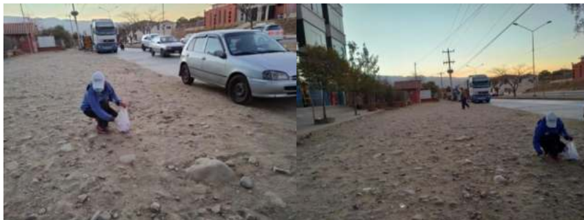
Fig. 3.29. Acopio de agregados en el distrito 7.
