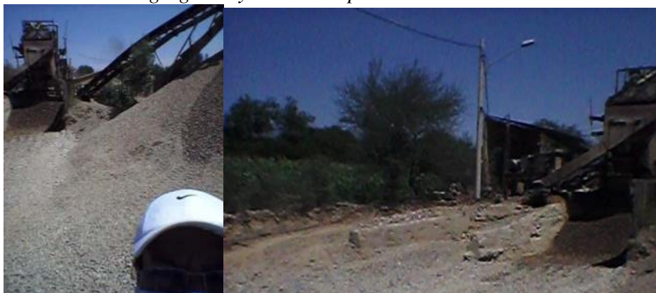
Fig.4.2. Extracción de agregados y visita a la planta trituradora Áridos “16 de enero”.
