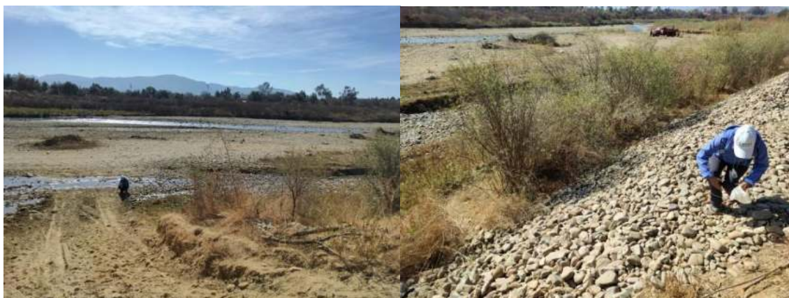
Fig. 3.39. Acopio de agregados en el distrito 12.
