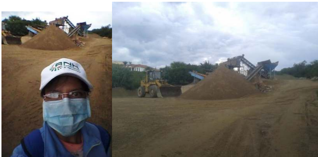
Fig. 4.3. Extracción de agregados y visita a la planta trituradora Áridos “Fernández”.
