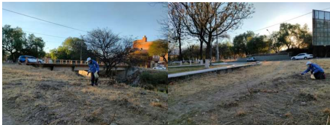
Fig. 3.31. Acopio de agregados en el distrito 8.
